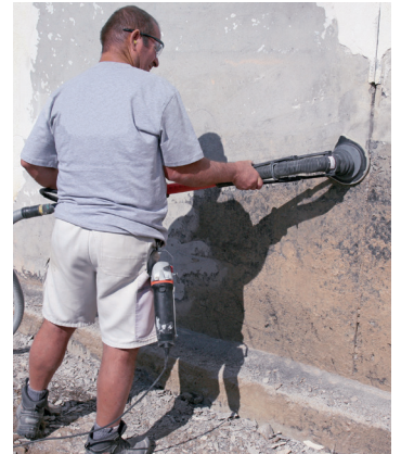
Bitumen schleifen mit dem PKD-Schleifteller
