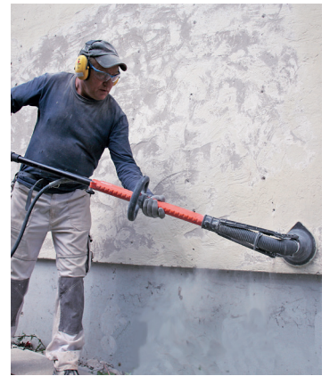
Alte Farbe und Putz entfernen
